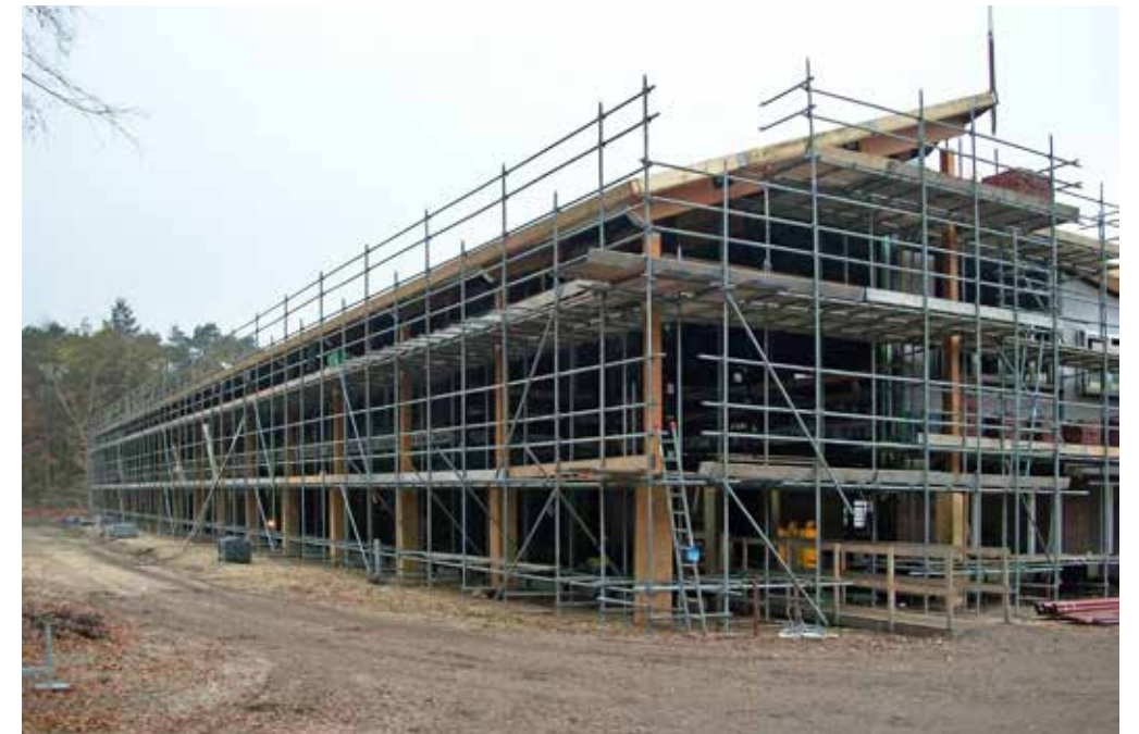
Onder meer ten behoeve van het metselwerk, is het gebouw geheel in de steigers gezet
